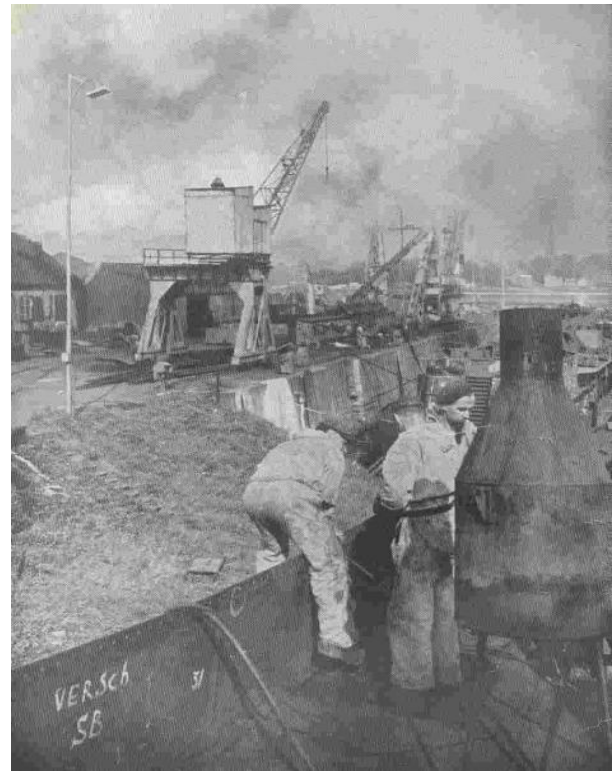
Klinknagels heet stoken op de voormalige ASM-werf
